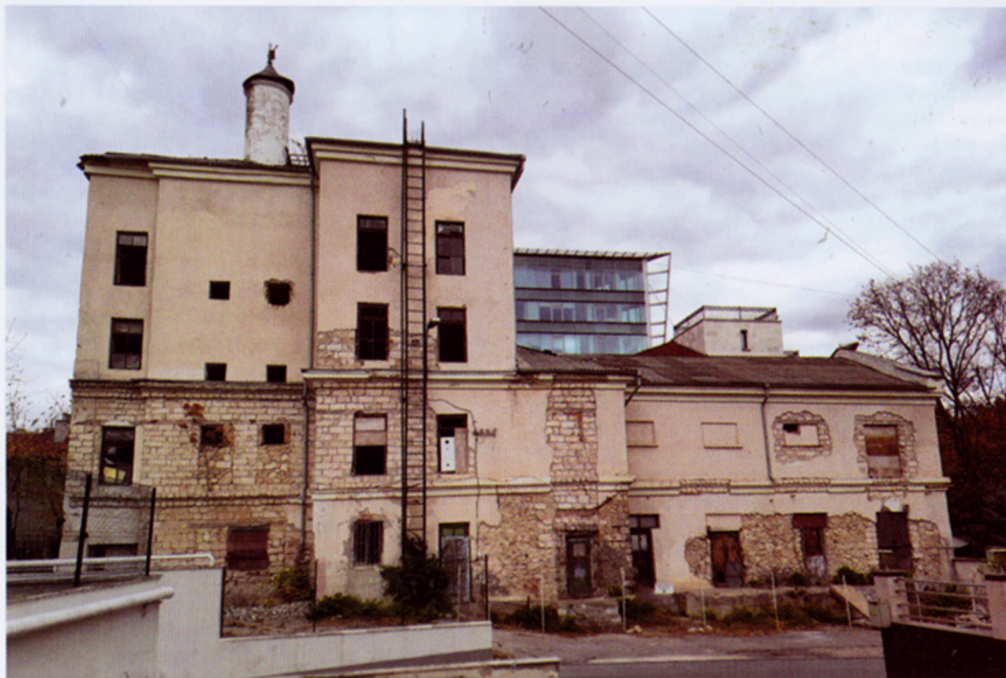
Здание бывшего пивзавода «Богемия» в Кишиневе на ул. Сфатул Цэрий фото 2021 г.
